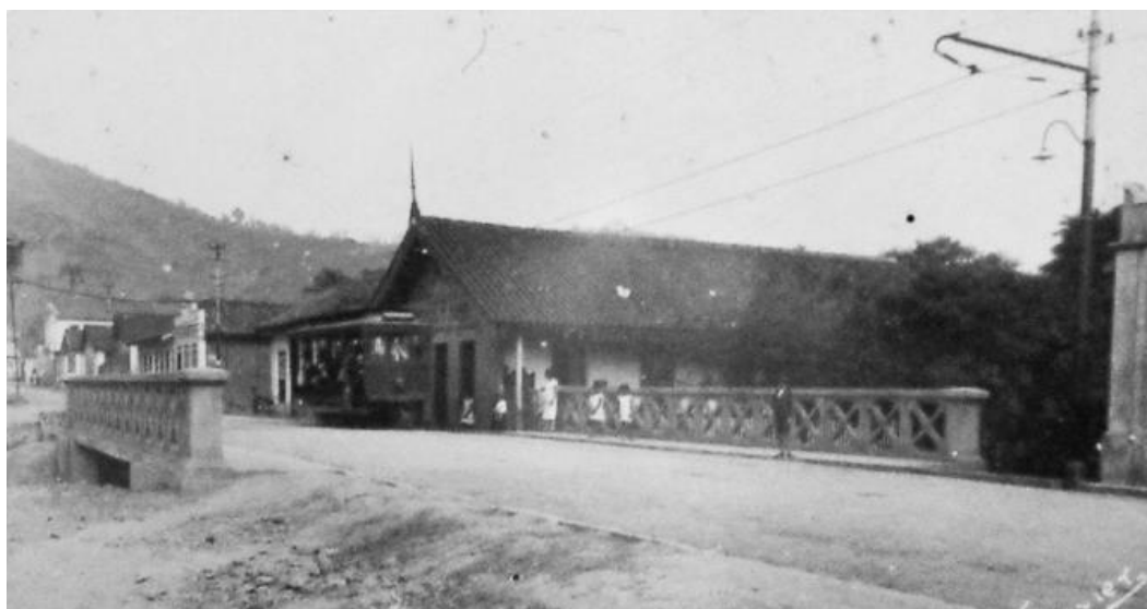
Foto 1 – Bonde Elétrico na ponte do Rio Limoeiro na Vila Laroca.
