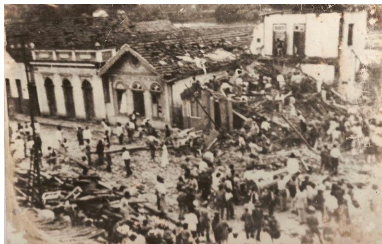
Foto 8 – Explosão do Paiol de Munições.
